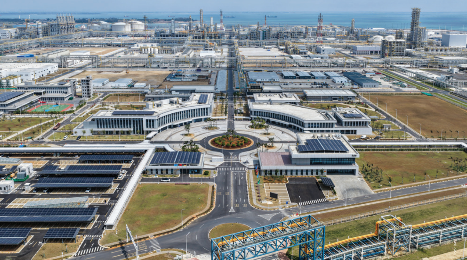
Der neu errichtete Verbundstandort der BASF in Zhanjiang.
